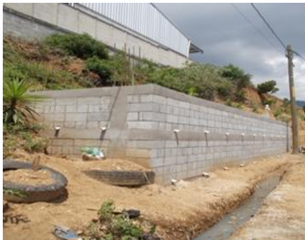
MURO DE CONTENCIÓN
