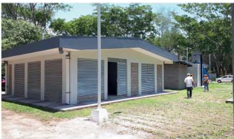
5. Construcción de Planta de Tratamiento AIES CEPA, Departamento de La Paz Monto invertido: $2,434,102.63 *Proyecto de Seguimiento
