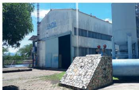
9. Planta Potabilizadora Las Pavas ANDA, Departamento de La Libertad Monto invertido: $62,128,439.41
