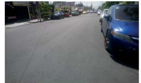
11. Mantenimiento rutinario de calles del municipio de S.S. Grupos 1 y 2 Alcaldía Municipal de San Salvador, Departamento de San Salvador Monto invertido: $1,189,328.90
