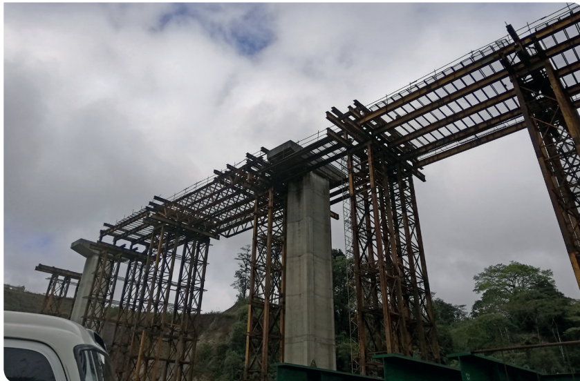
Figura 7. Carretera a San Carlos, sección Sifón - Ciudad Quesada (La Abundancia). Fuente: LanammeUCR.
