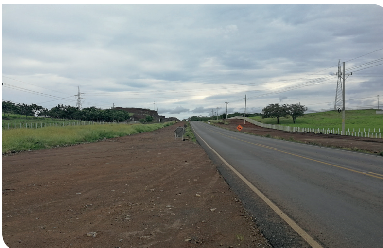
Figura 3. Ruta Nacional 1, Sección Cañas – Limonal. Fuente: LanammeUCR.
