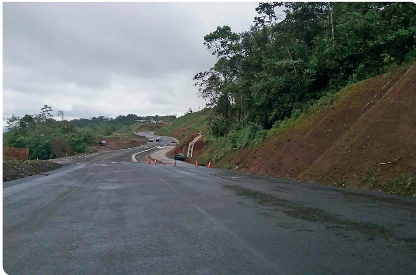
Figura 6. Carretera a San Carlos, sección Sifón - Ciudad Quesada (La Abundancia). Fuente: LanammeUCR.
