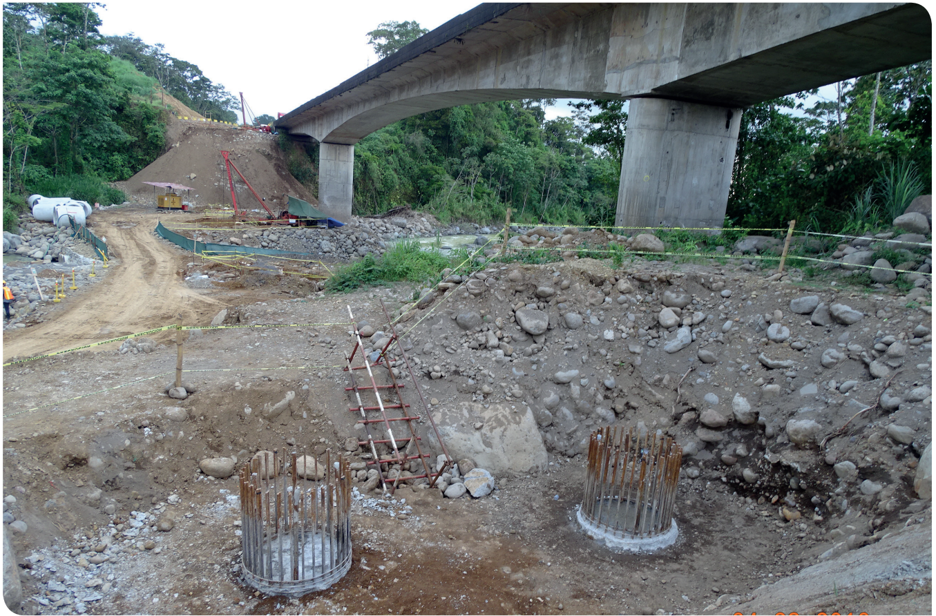
Figura 9. Ruta Nacional N°32, Sección: intersección Ruta Nacional N°4 (Cruce a Sarapiquí) - Limón. Fuente: LanammeUCR.
