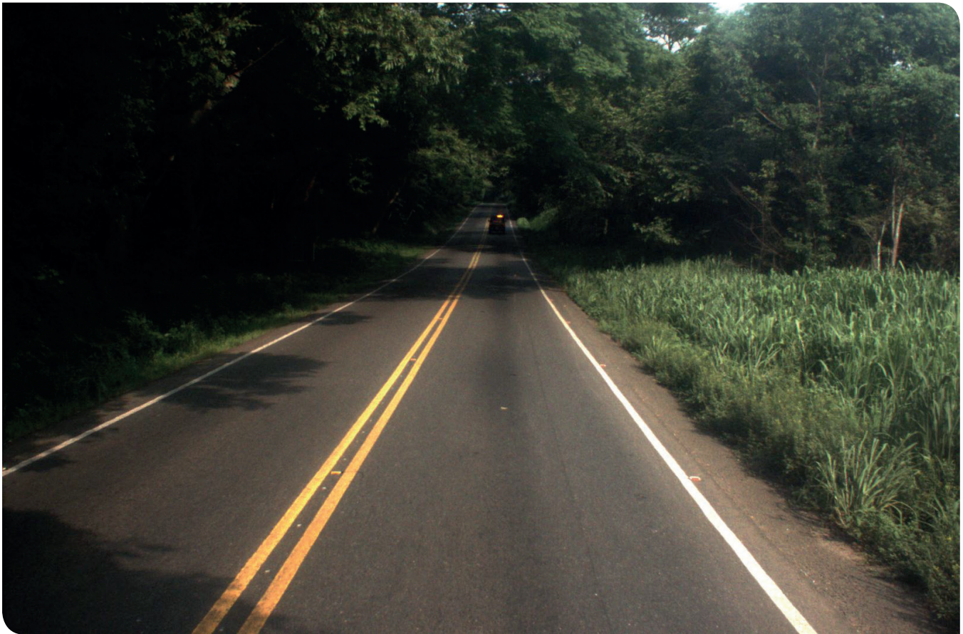
Figura 5. Carretera Interamericana Norte Tramo San Gerardo-Barranca. Fuente: LanammeUCR.
