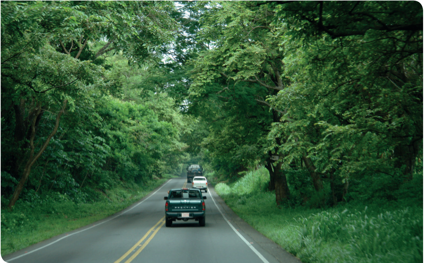
Figura 4. Carretera Interamericana Norte Tramo Limonal-San Gerardo. Fuente: LanammeUCR.
