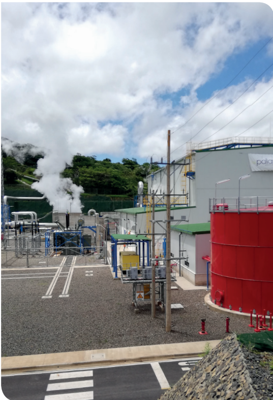
Figura 12. Instalaciones de la Planta Geotérmica Las Pailas II. Fuente: LanammeUCR.
