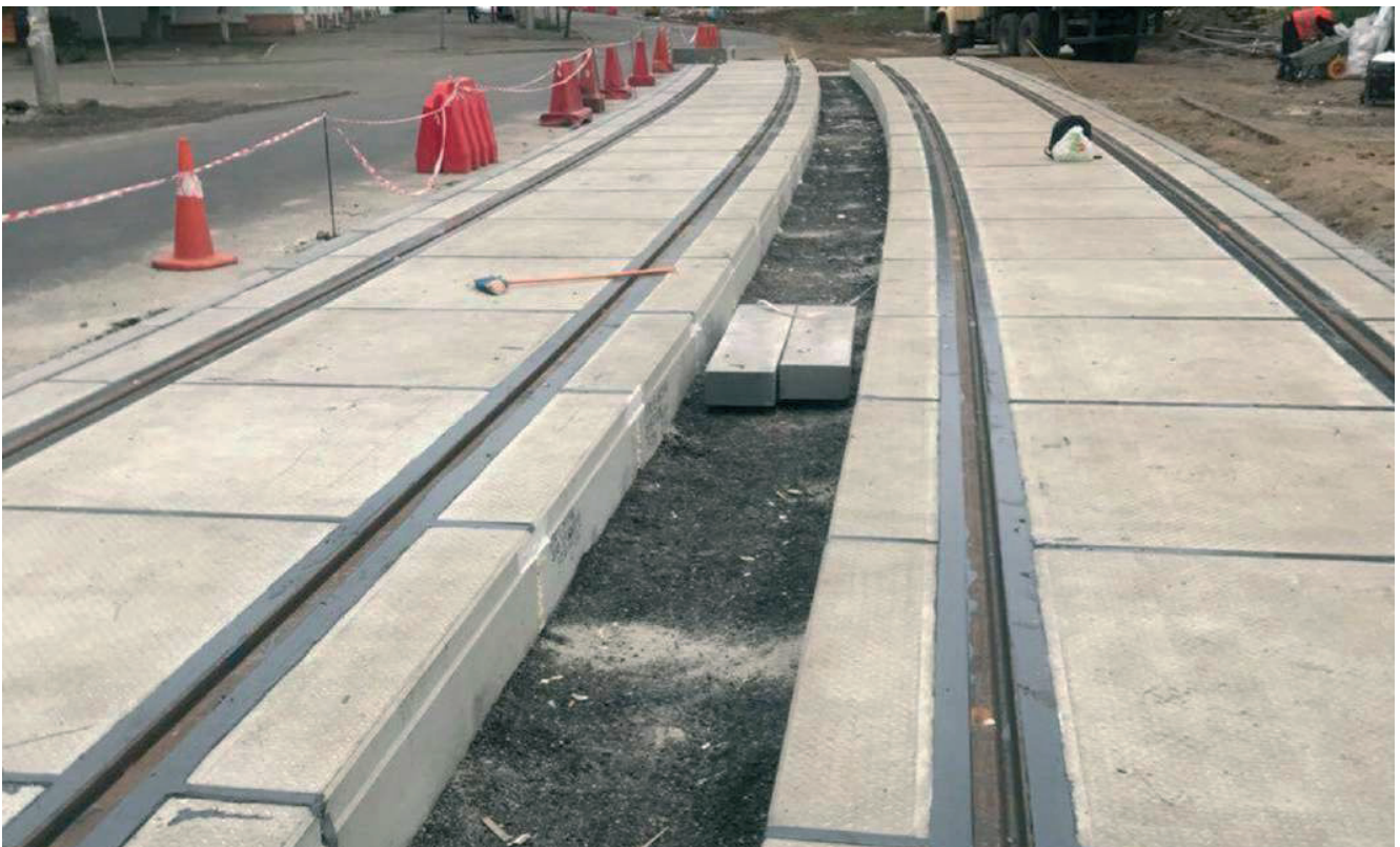
Рисунок – Рейки 60R2 заливають поліуретановим матеріалом Sika Icosit KC
