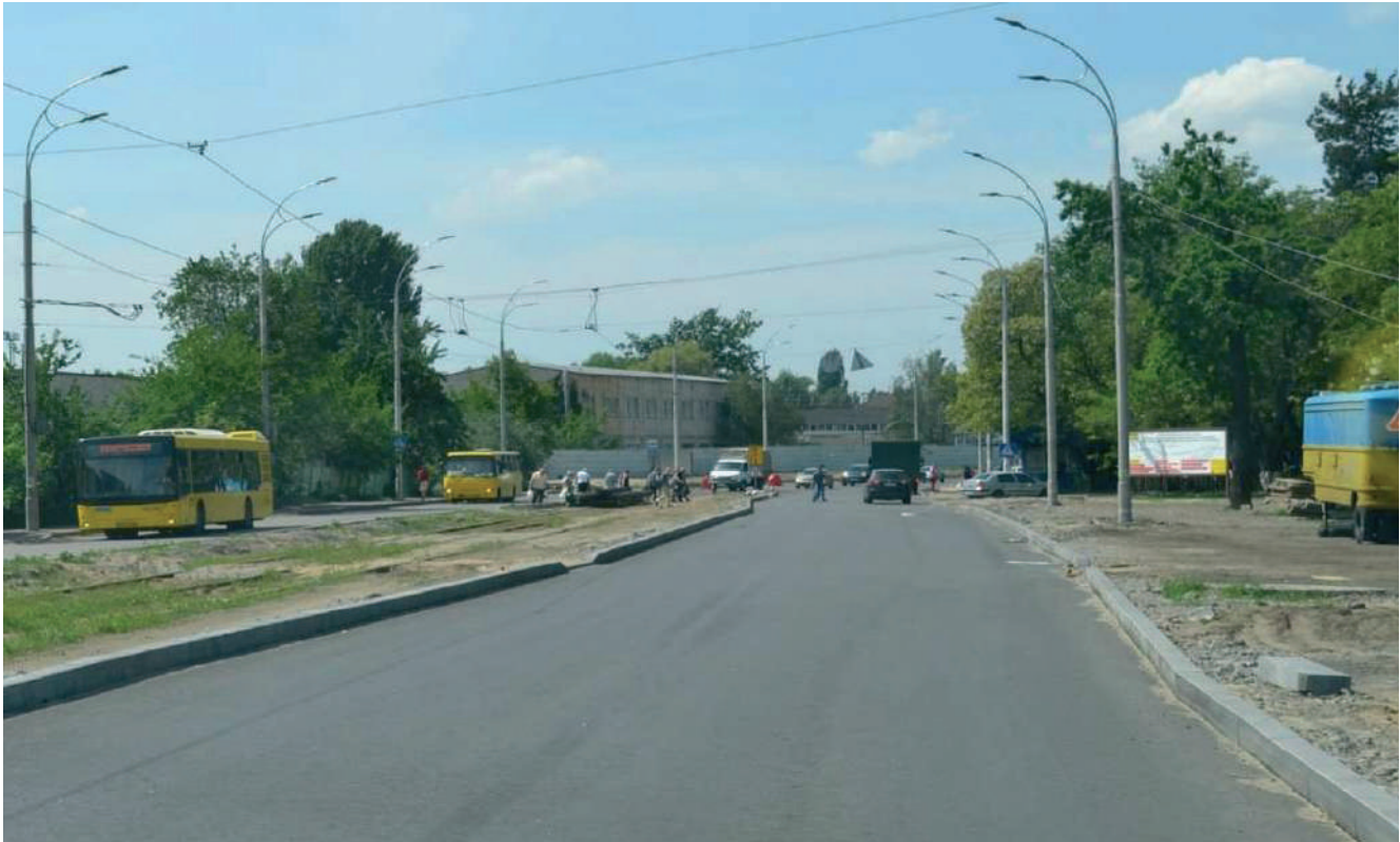
Рисунок – Ділянка автодороги після проведення капітального ремонту від ПК 13+58.90 (вул. Марганецька) до ПК 24+71.00 (вул. О. Довбуша)
