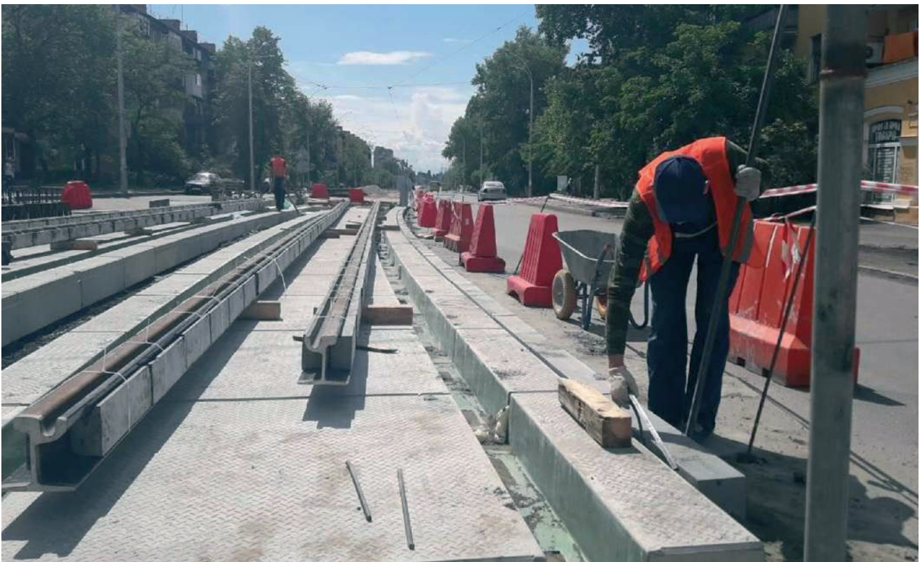
Рисунок – Прикріплення до рейок 60R2 бетонних баластів
