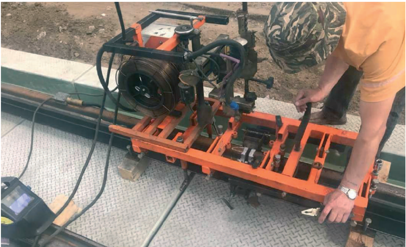
Рисунок – Зварювання трамвайних рейок 60R2 між собою за допомогою електродугової автоматизованої зварки
