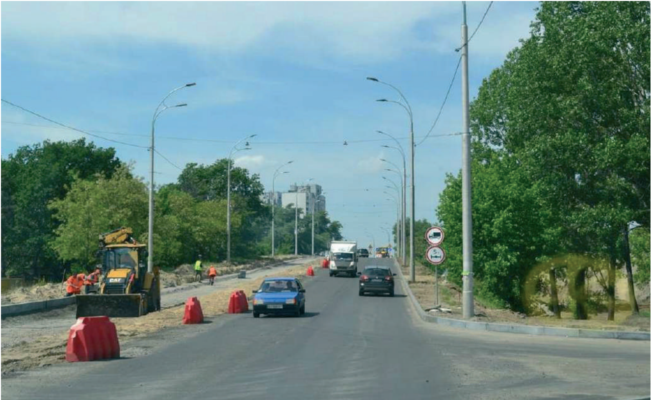
Рисунок – Ділянка автодороги після проведення капітального ремонту від ПК 6+79.60 (вул. Трактористів) до ПК 13+58.9 (вул. Марганецька)
