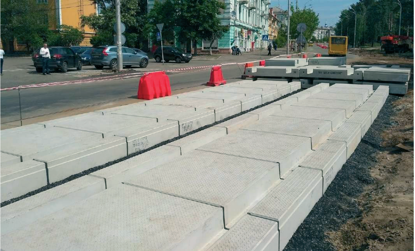
Рисунок – Влаштування трамвайної колії блочного типу з залізобетонними плитами
