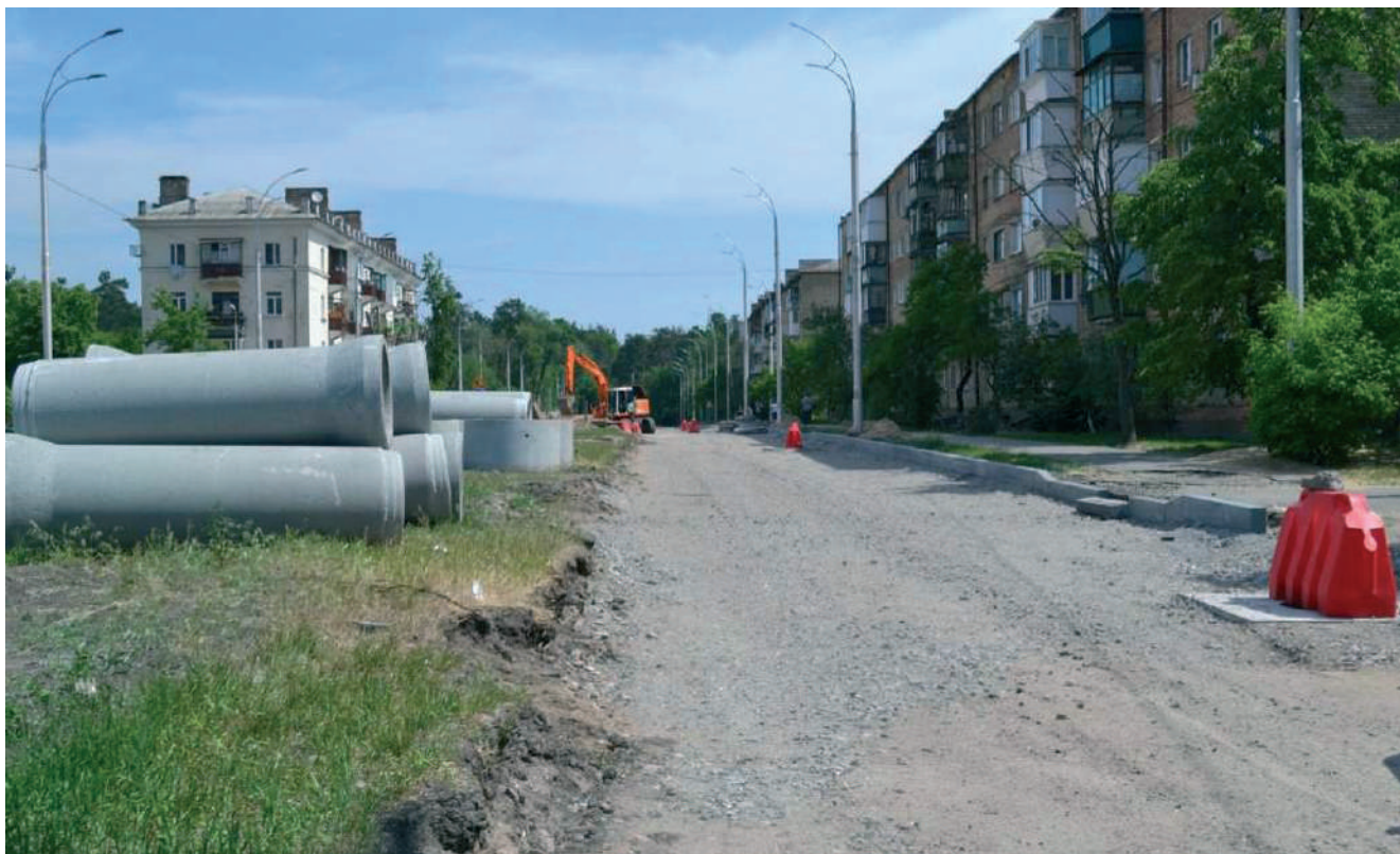
Рисунок – Підготовка перед влаштуванням колодязів типу ККС-2
