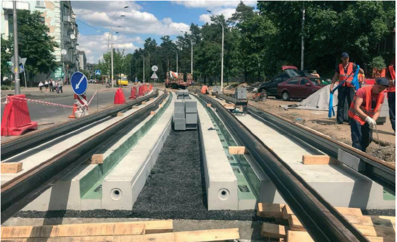
Рисунок – Повторне очищення плит каналів і рейок, потім рейки очищають від іржі та бруду, знежирюють, після чого прогрунтовуються ґрунтовкою
