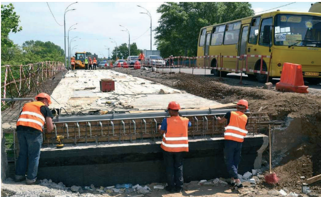
Рисунок – Улаштування монолітної залізобетонної плити мостового полотна шляхопроводу
