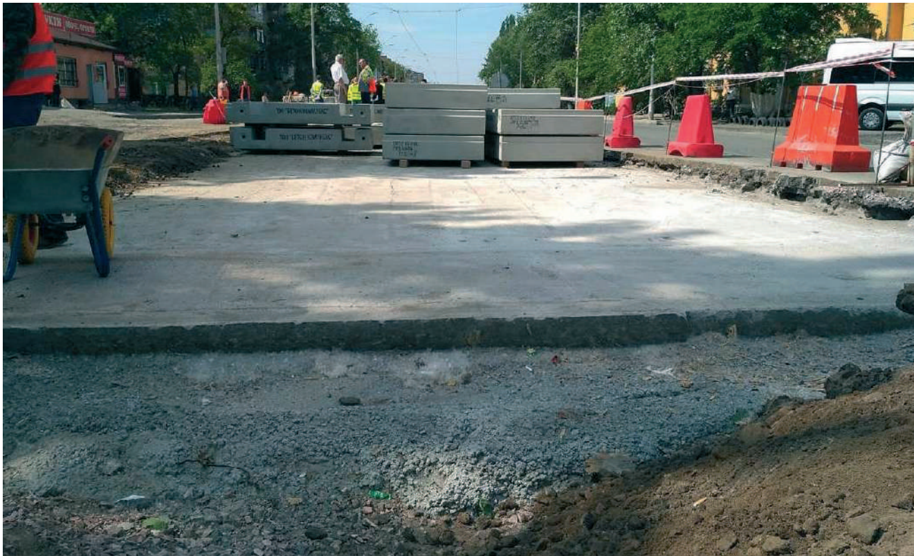
Рисунок – Влаштування бетонного шару в конструкції проектної трамвайної колії
