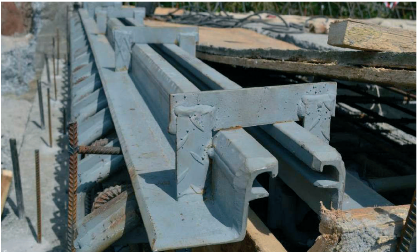
Рисунок – Виконана конструкція деформаційного шва в зоні проїзної частини мостового полотна (станом на 16.05.2018 р.)
