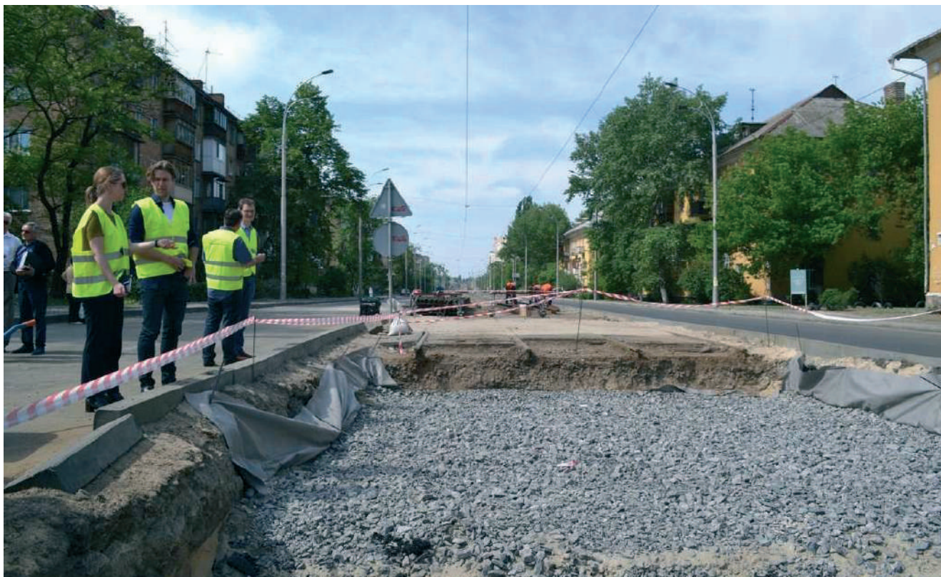
Рисунок – Влаштування геотекстилю Турар SF-49 і щебеневого шару в конструкції проектної трамвайної колії
