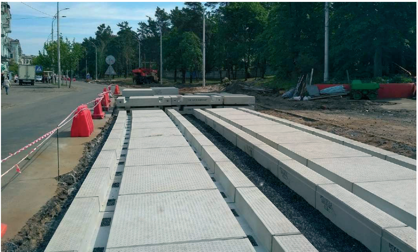
Рисунок – Влаштування трамвайної колії блочного типу з залізобетонними плитами по вул. Алма-Атинської
