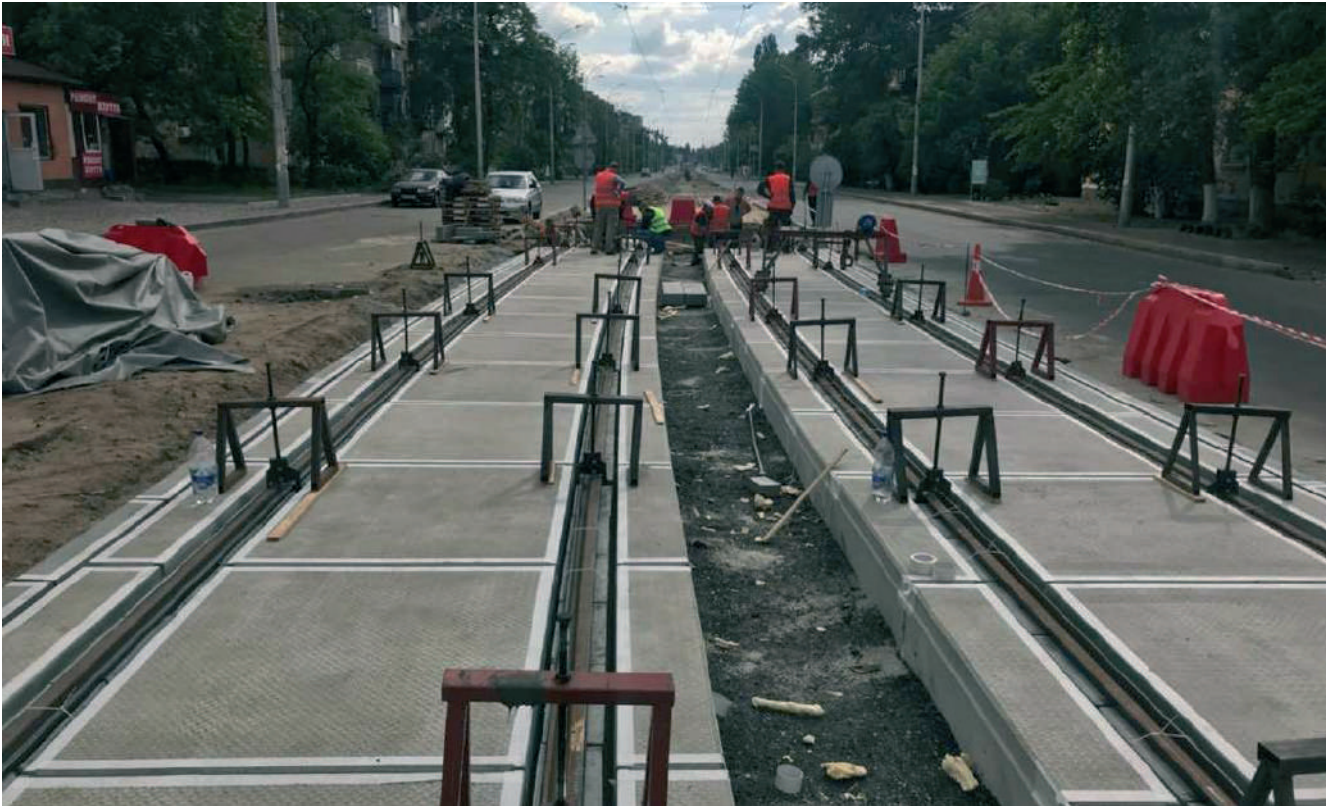
Рисунок – Рейки 60R2 вивішують і виставляють на проектні вертикальні відмітки
