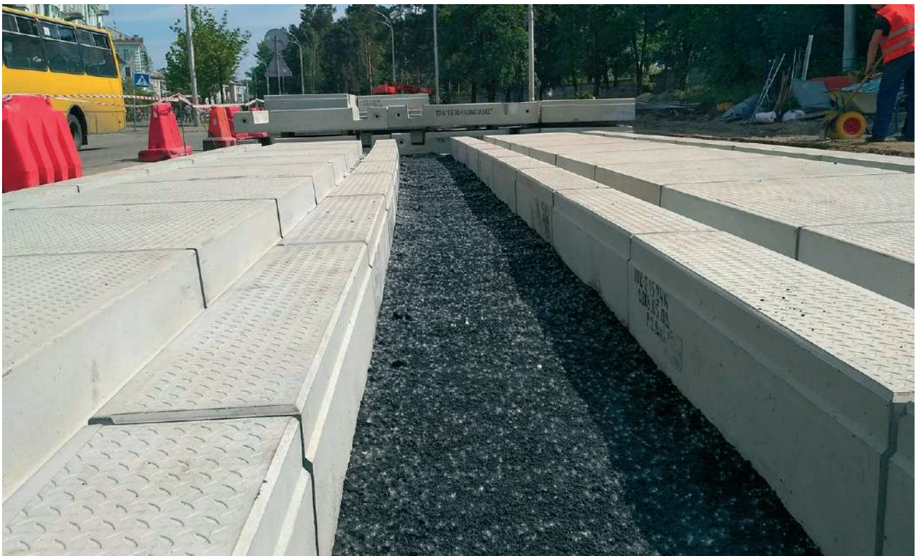
Рисунок – Після укладання георешітки і поетапного засипання та ущільнення щебеню товщиною 120 мм фракцією 40-70 та 80 мм фракцією 20-40 мм, поверхневу щебеневу подушку проливають бітумною емульсією (витрата 2,5 л/м 2 ) для кращого зчеплення дрібнозернистого асфальтобетону фракцією 10 мм (шар 3 см), який виконує функцію вирівнюючого шару та є підосною. Влаштування бетонного шару товщиною 200 мм
