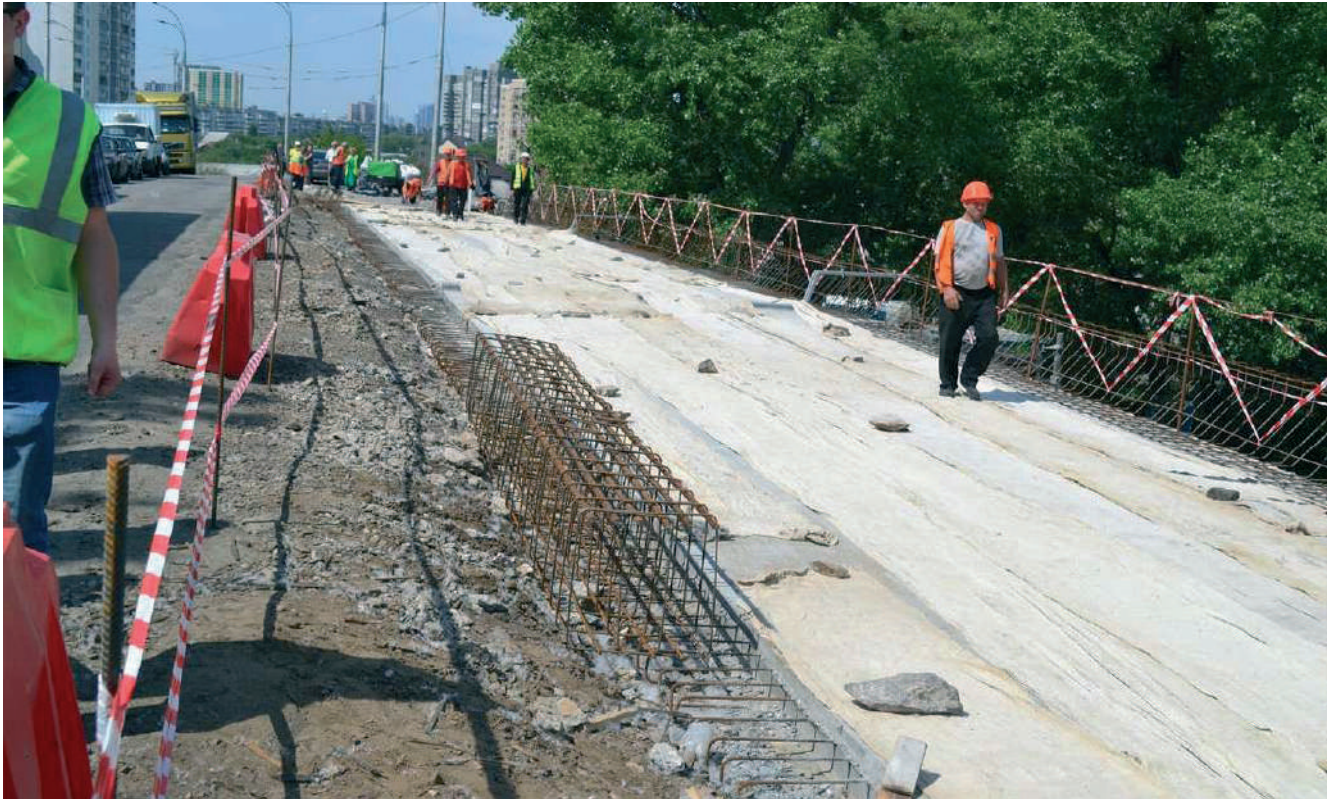
Рисунок – Набір міцності бетону монолітної залізобетонної плити мостового полотна шляхопроводу (технологічна перерва).
