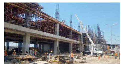
7. Ampliación de la Terminal de Pasajeros del Aeropuerto Internacional de El Salvador, San Óscar Arnulfo Romero y Galdámez, Etapa 1, Departamento de La Paz.
