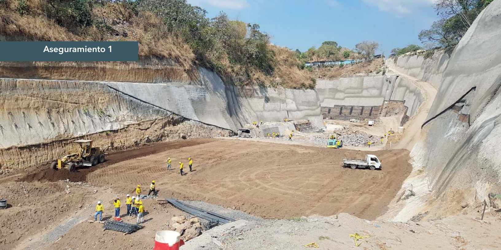
Construcción de Dique, tomada en visita de campo al proyecto, realizada el 19 de marzo de 2019.
