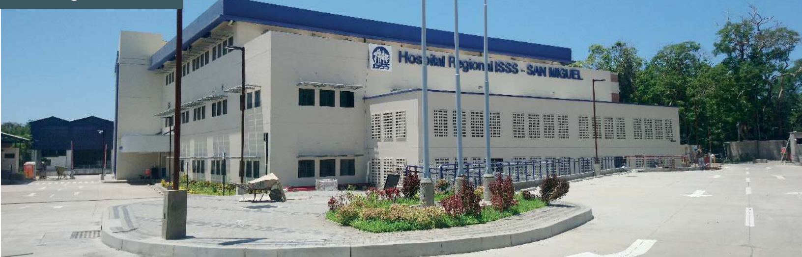
Vista de Fachada Occidente , tomada en visita de campo al proyecto, realizada el 25 de junio de 2019.
