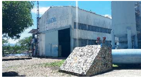
9. Rehabilitación de las Obras de Captación, Potabilización y Electromecánicas de la Planta Potabilizadora Las Pavas, Municipio de San Pablo Tacachico, Departamento de La Libertad, El Salvador
