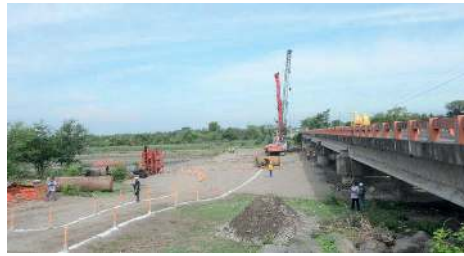
13. Ampliación y Rehabilitación Carretera CA02E, Autopista a Comalapa- Zacatecoluca, Departamento de La Paz. ** Proyecto Estudio de Caso
