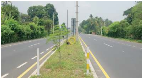
3. Mantenimiento Periódico de la Ruta CA08W, Tramo: CA01W (El Poliedro) - Sonsonate, Tramo IV
