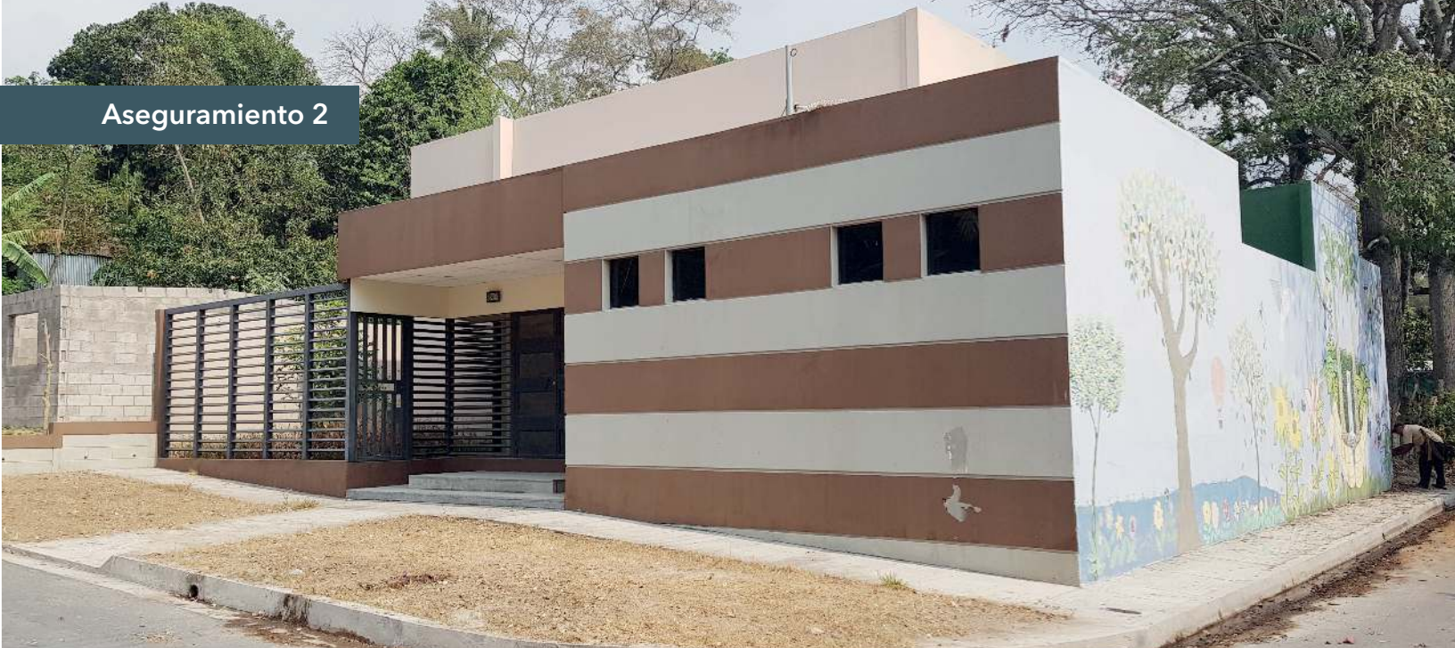
Construcción de Casa Comunal., tomada en visita de campo al proyecto, realizada el 09 de abril de 2019.
