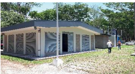
5. Construcción de la Planta de Tratamiento de Aguas Residuales para el Aeropuerto Internacional de El Salvador, San Óscar Arnulfo Romero y Galdámez, Departamento de La Paz . *Proyecto de Seguimiento.
