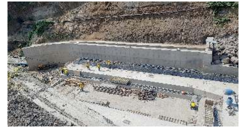
1. Construcción de Obras de Amortiguamiento del Macro Drenaje Pluvial del Área Metropolitana de San Salvador, El Salvador" (Laguna de Laminación)
