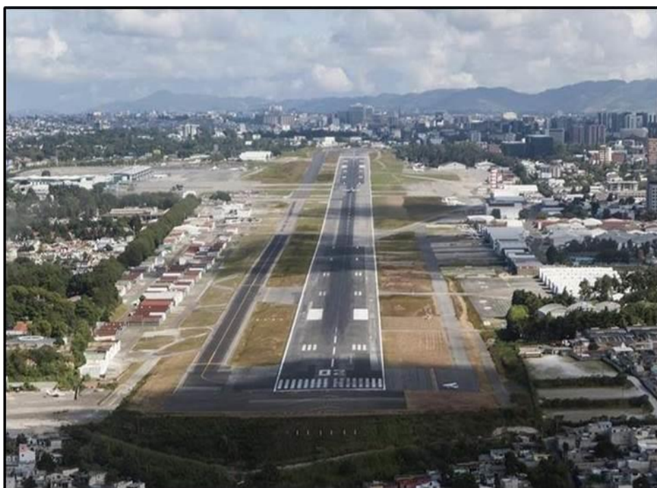
Reparación de Pista Activa del Aeropuerto Internacional La Aurora
