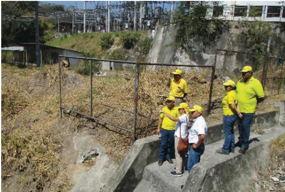
Fotografía tomada en la visita de campo al proyecto, realizada el 06 de marzo del 2018.
