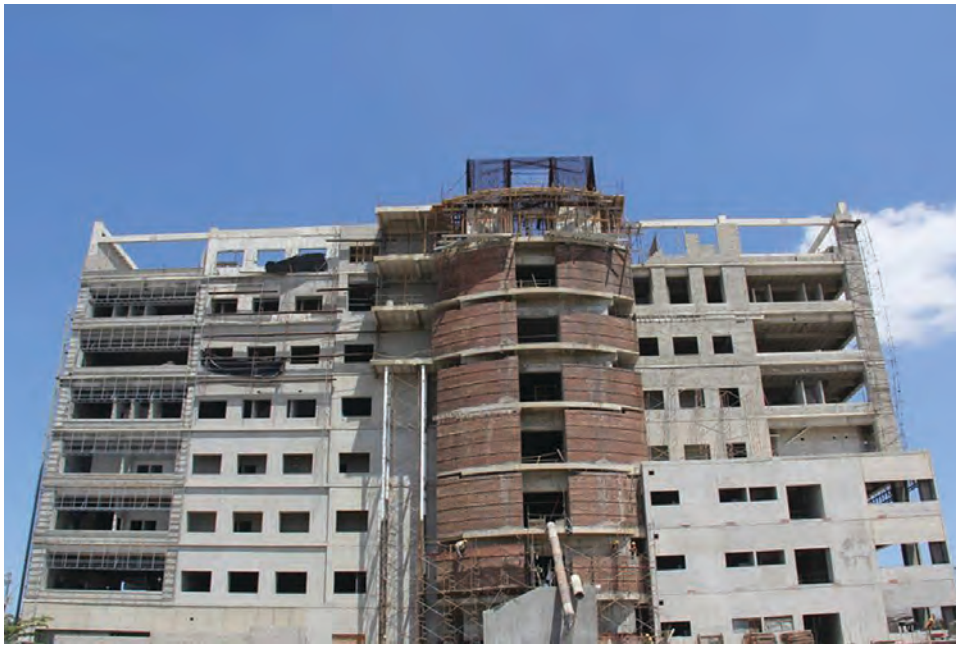
Fotografía tomada en la visita de campo al proyecto, realizada el 16 de marzo del 2018.
