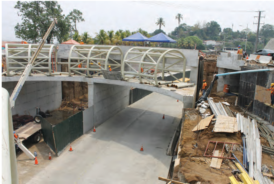
Fotografía tomada en la visita de campo al proyecto, realizada el 25 de marzo del 2018.
