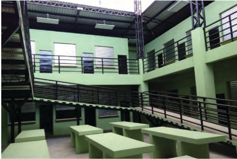
Fotografía tomada en la visita de campo al proyecto, realizada el 21 de marzo del 2018.
