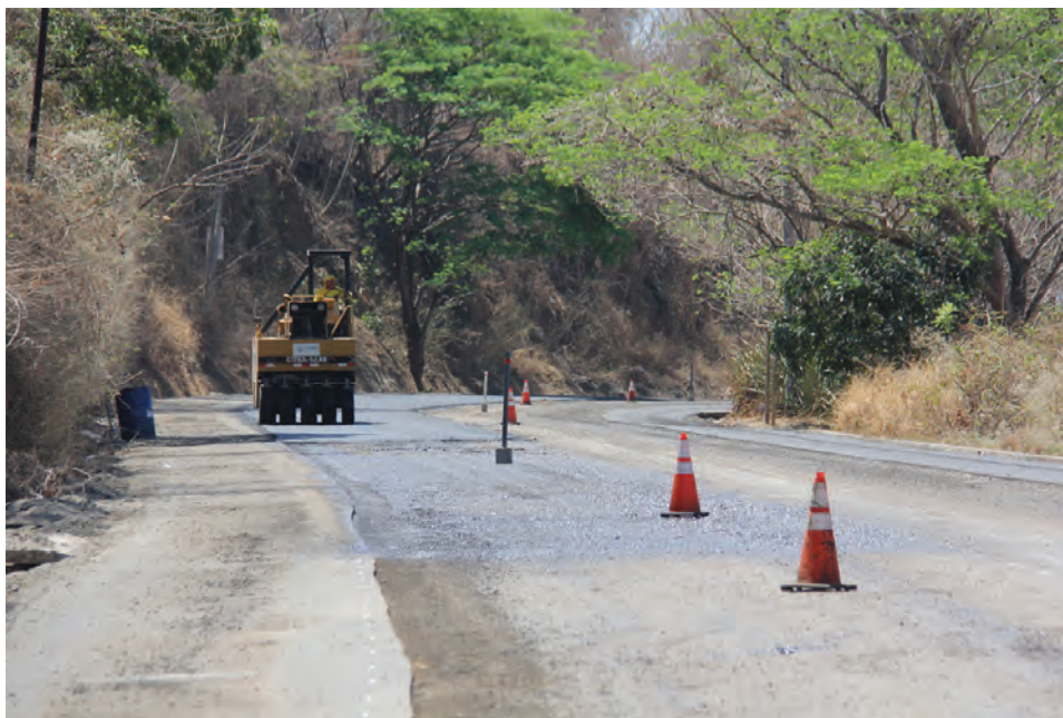
Fotografía tomada en la visita de campo al proyecto, realizada el 8 de marzo del 2018.
