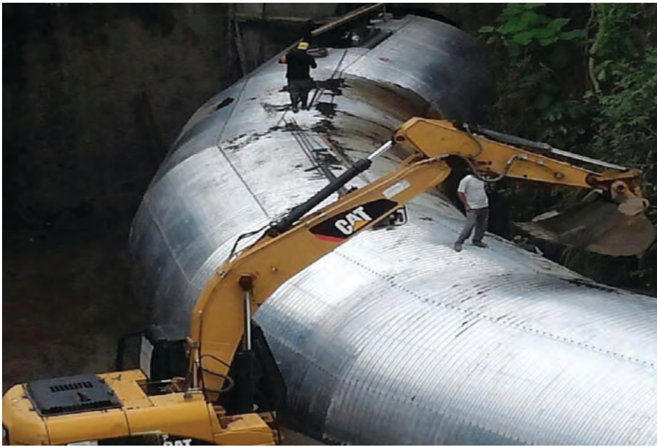
Fotografía en documentos divulgados de manera reactiva por la UES. Unidad de Desarrollo Físico. Equipo de supervisión de bóveda.
