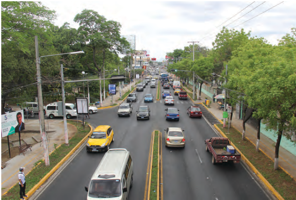
Fotografía tomada en la visita de campo al proyecto, realizada el 13 de marzo del 2018.
