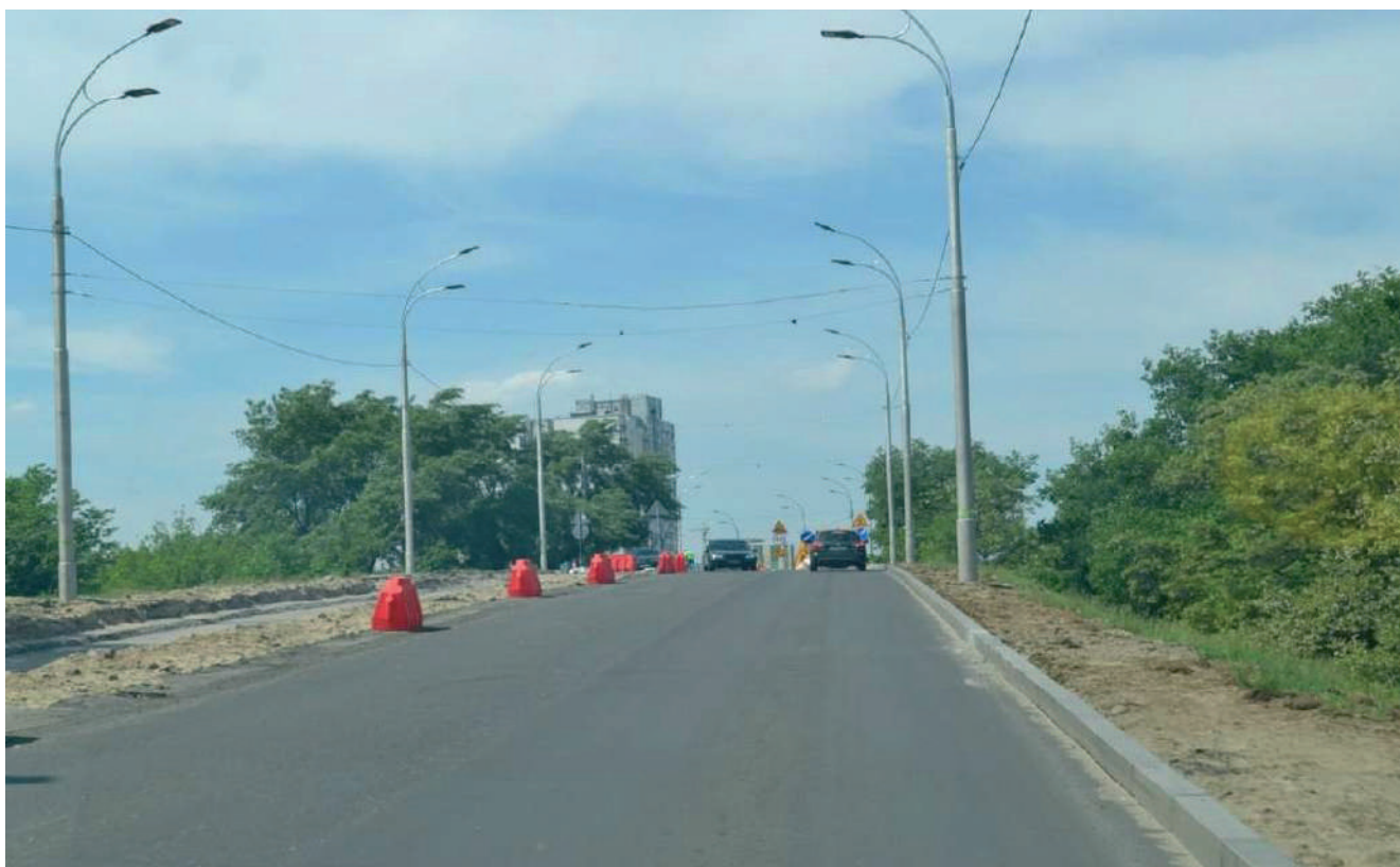
Рисунок — Ділянка автодороги при заїзді на шляхопровід від ПК 6+79.60 (вул. Трактористів) після проведення капітального ремонту
