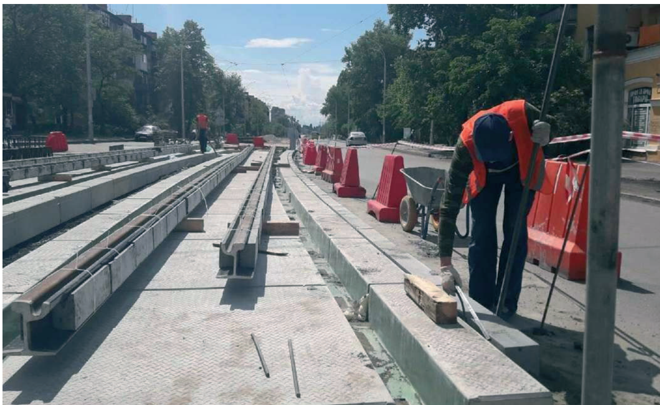
Рисунок – Прикріплення до рейок 60R2 бетонних баластів
