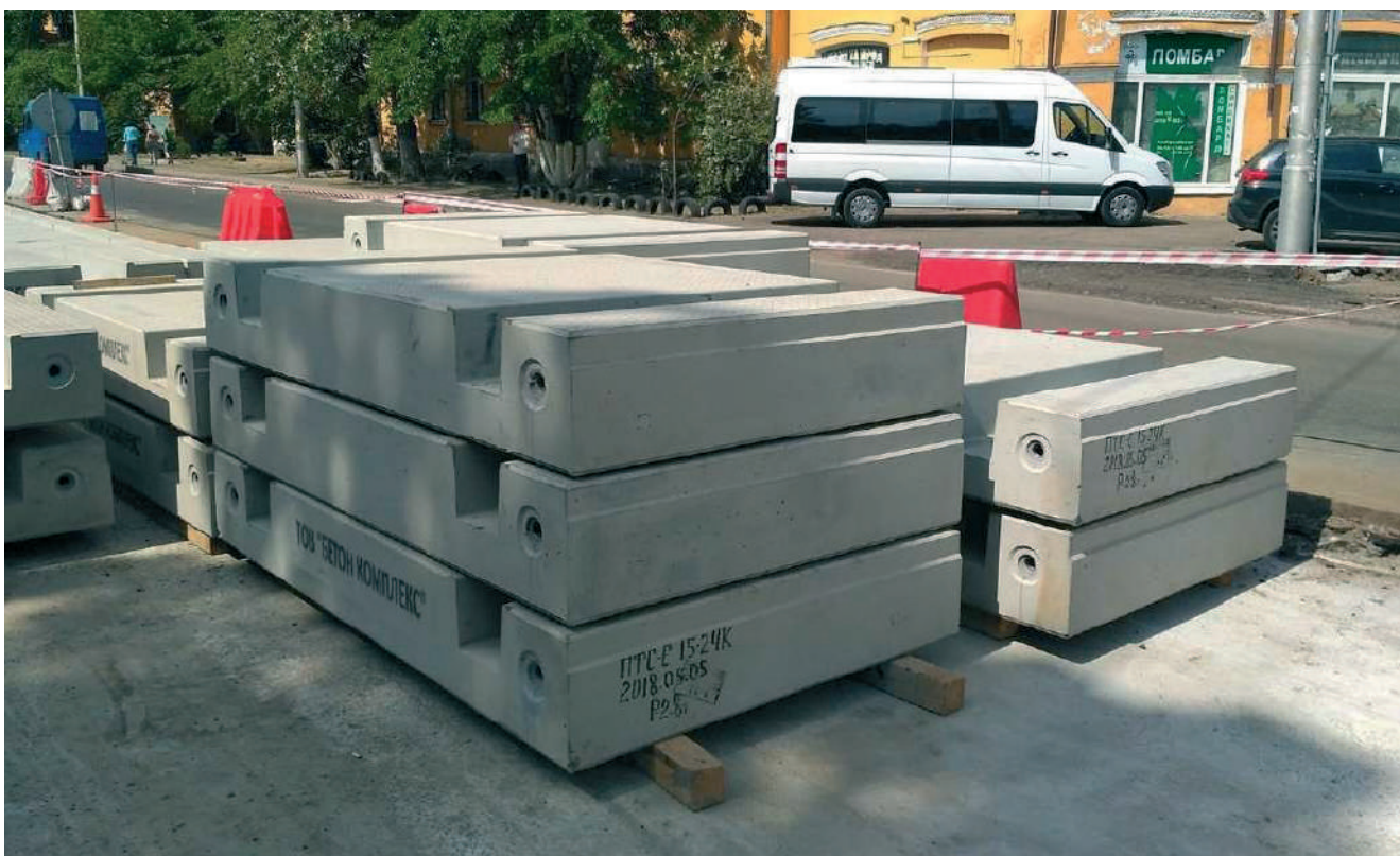
Рисунок – Залізобетоні плити блочного типу виробництва компанії ПБГ «Ковальская»
