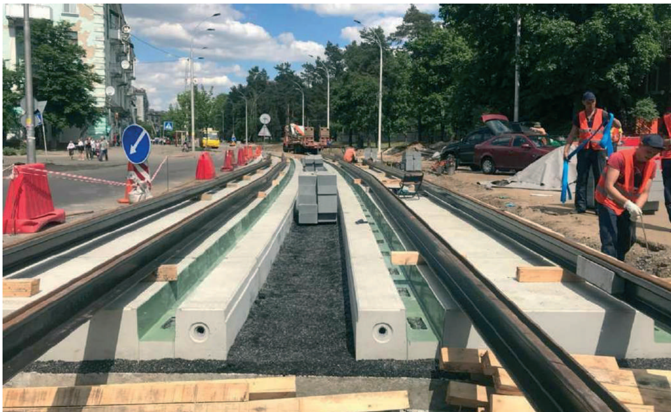
Рисунок – Повторне очищення плит каналів і рейок, потім рейки очищають від іржі та бруду, знежирюють, після чого прогріваються ґрунтовкою
