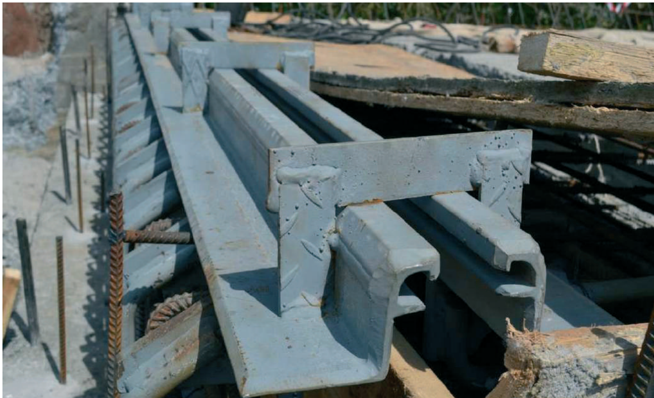
Рисунок – Виконана конструкція деформаційного шва в зоні проїздної частини мостового полотна (станом на 16.05.2018 р.)
