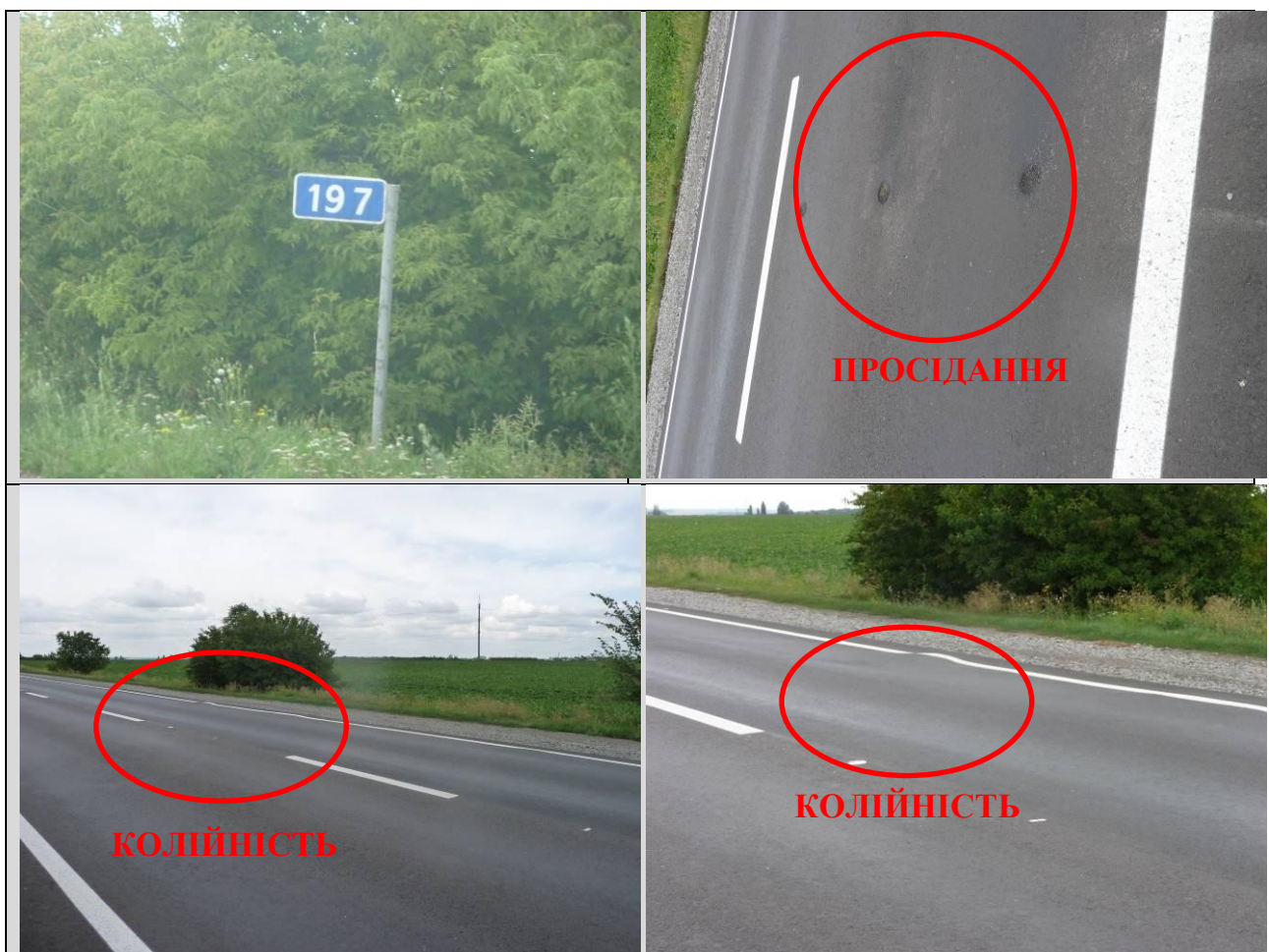
Рівненська область автомобільна дорога М-19 - км 213+650 ліквідація просідання і сітки тріщин згідно з зауваженнями ДП «Дорцентр».
