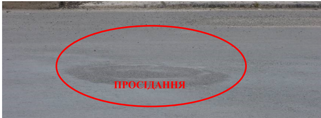
Рівненська область автомобільна дорога М-19 - км 213+650 ліквідація просідання і сітки тріщин згідно з зауваженнями ДП «Дорцентр».
