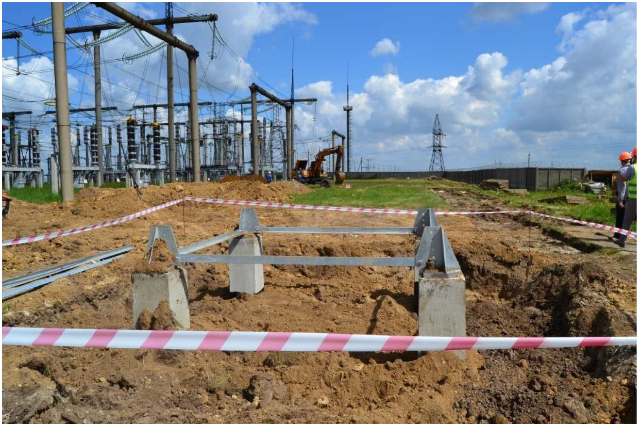
Світлина 3: Улаштування фундаменту під трансформаторний портал 330 кВ
