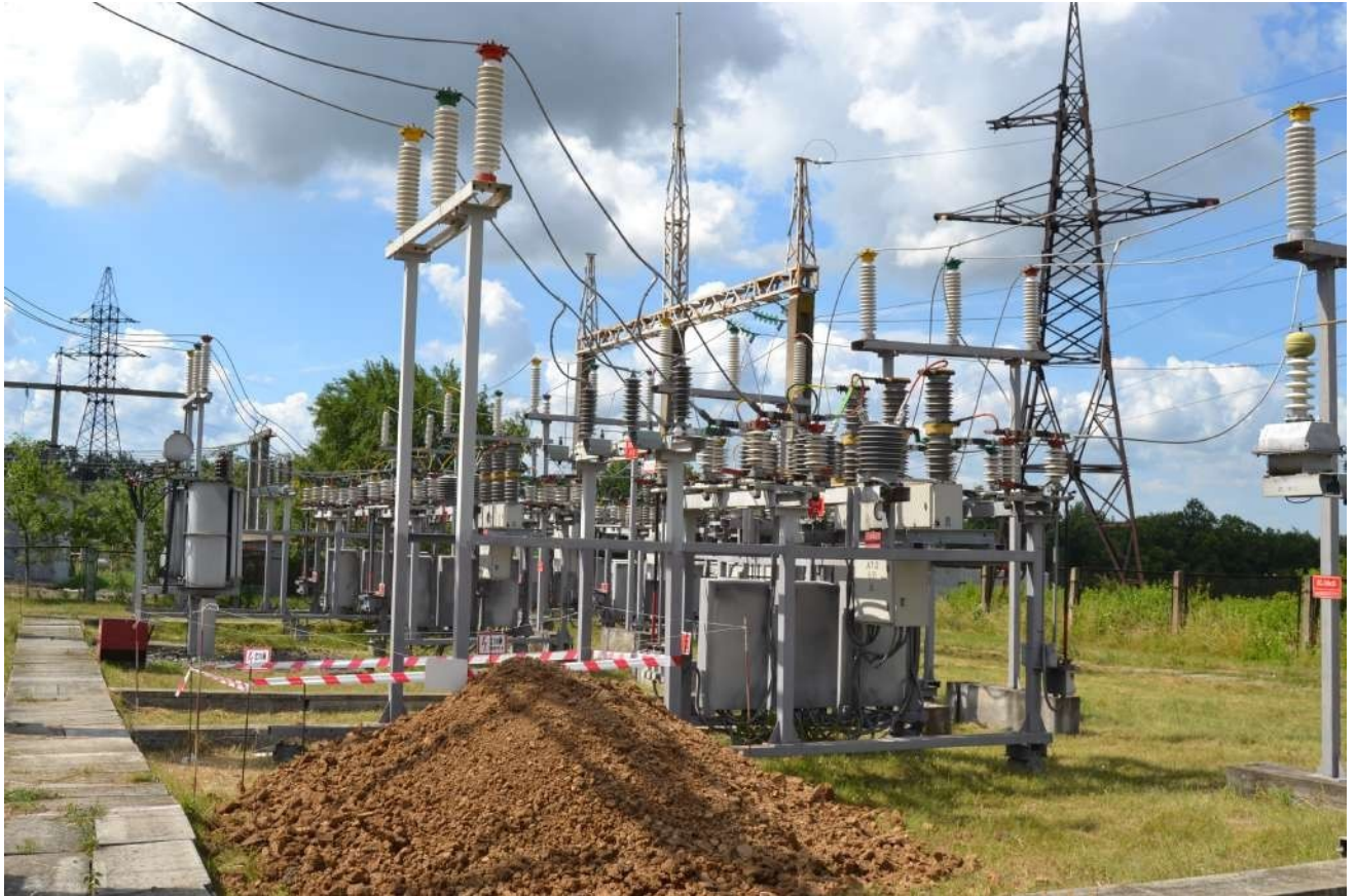
Світлина 8: Фрагмент існуючого ВРП 35 кВ
