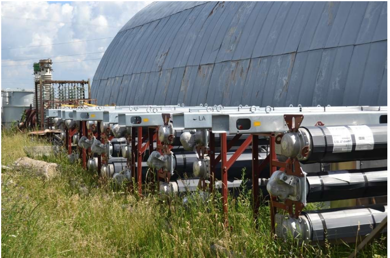
Світлина 4: Елегазові вимикачі 110 кВ виробництва «Siemens»
