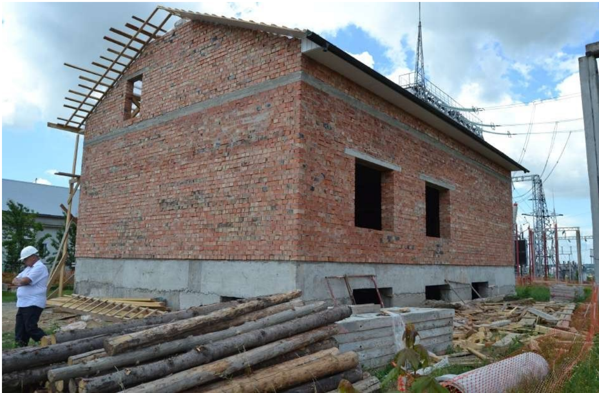
Світлина 1: Стан будівництва ЗПК №2, що відстає від графіку
