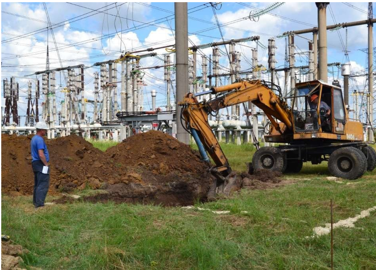
Світлина 2: Земляні роботи для влаштування фундаменту під портали 330 кВ
