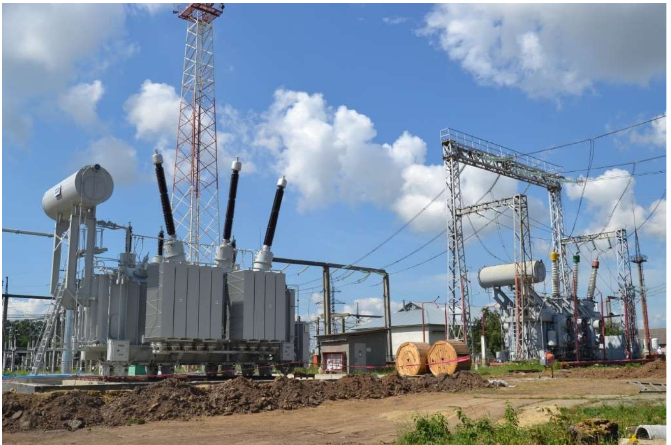
Світлина 5: Встановлений на проектне місце автотрансформатор АТЗ (поки не ошинований)
