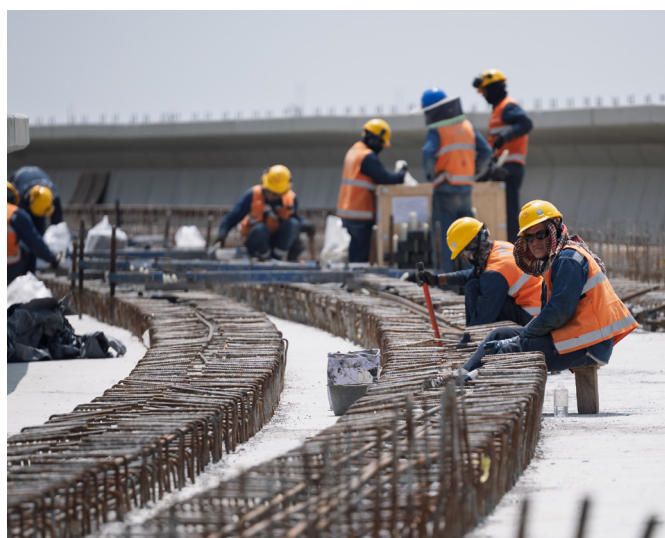
Construcción de la Línea 1 del Metro de Bogotá
