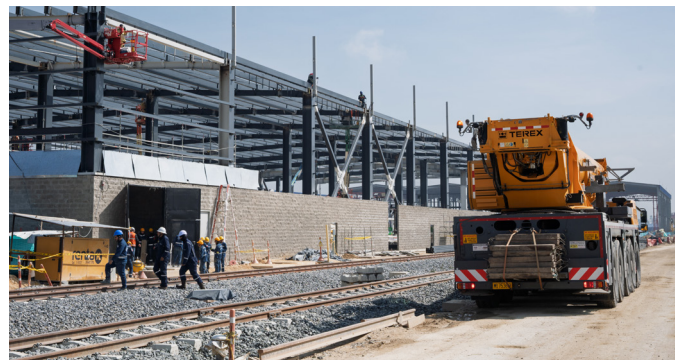
Construcción de infraestructura en Bogotá
