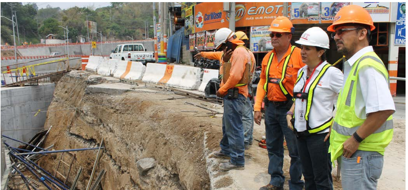
Visita in situ en El Salvador
