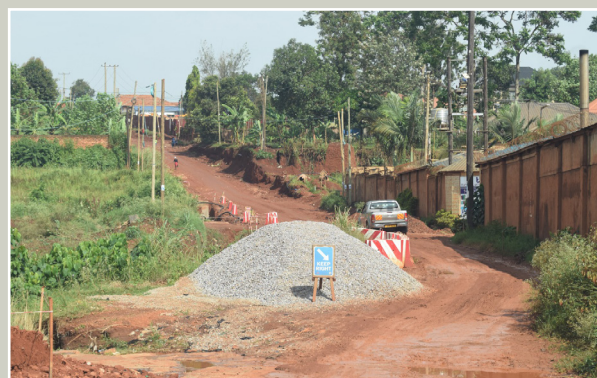
Uganda: Foto tomada durante la construcción de la carretera de Katalamwa
