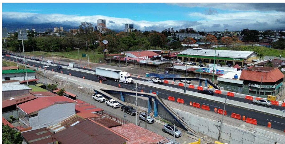
Figura 9. Vista acceso norte, Diseño y construcción del paso a desnivel Hatillo 6 (CONAVI)
