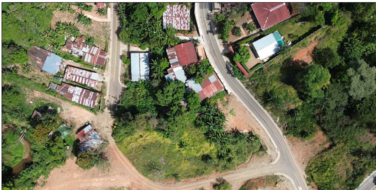
Figura 31. Faltante de área por asfaltar, Tierra Prometida – Bono Comunal (MIVAH-BANHVI)
