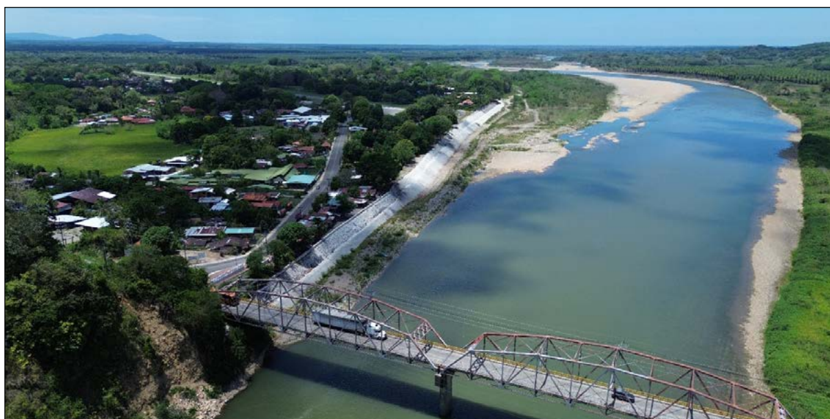
Figura 10. Vista del muro tomado del lado este, Obras de protección en los ríos Balsar y Grande de Térraba (CNE/SENARA)
