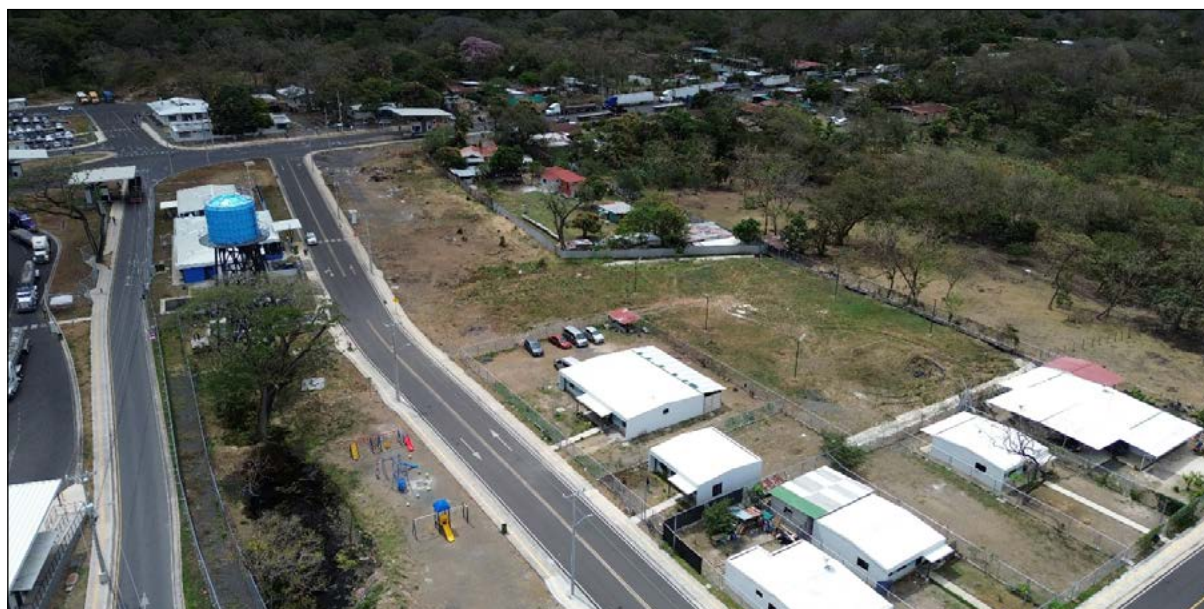
Figura 15. Entrada a Centro de Control Fronterizo de Peñas Blancas desde Costa Rica, COMEX
