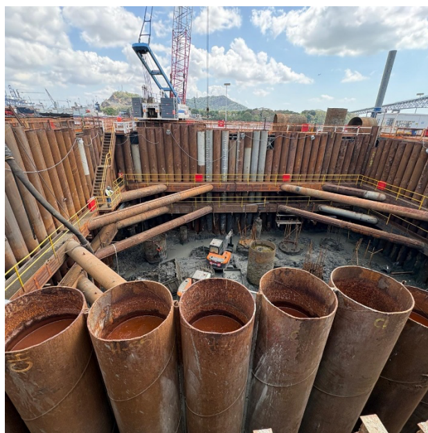
Foto 2. Cofferdam o tablestacados de contención para mantener la zona seca y poder hincar los pilotes
