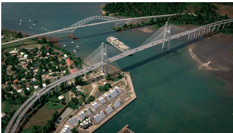
Figura 5. Cuarto Puente sobre el Canal
