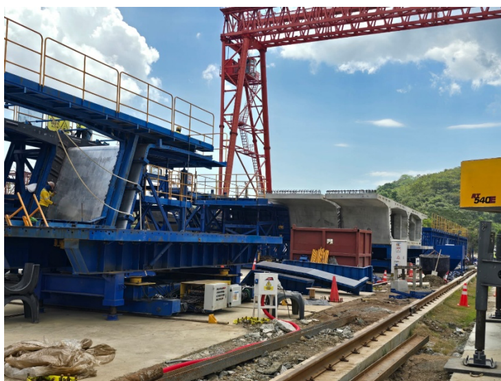
Foto 4. Planta de prefabricado de dovelas para el tablero del puente principal
