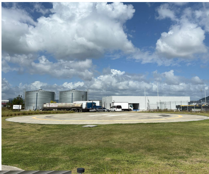
Foto 7. Helipuerto y oficinas
